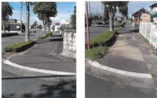
9月：バス通り東側の歩道の段差解消（新田西） (自転車やベビーカーの通行に支障があった)
