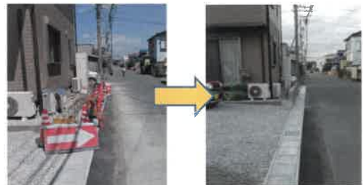
9月：林北組で側溝未整備部分での新たな敷設
