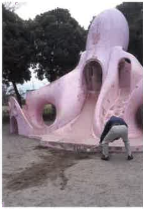
2月：蒲北公園遊具修繕と砂場改良 (破損による突起物修繕)
