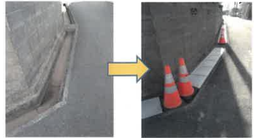
6月：側溝の蓋掛け(中根西マンション建設工事横)
