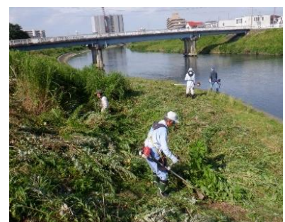
八幡瀬橋上流
