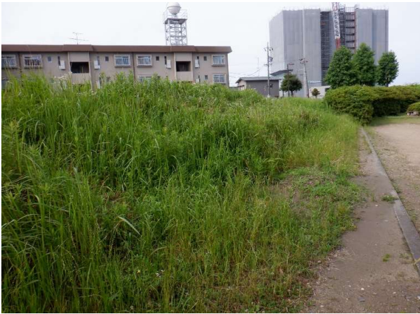
八幡瀬橋下流270m付近 着手前
