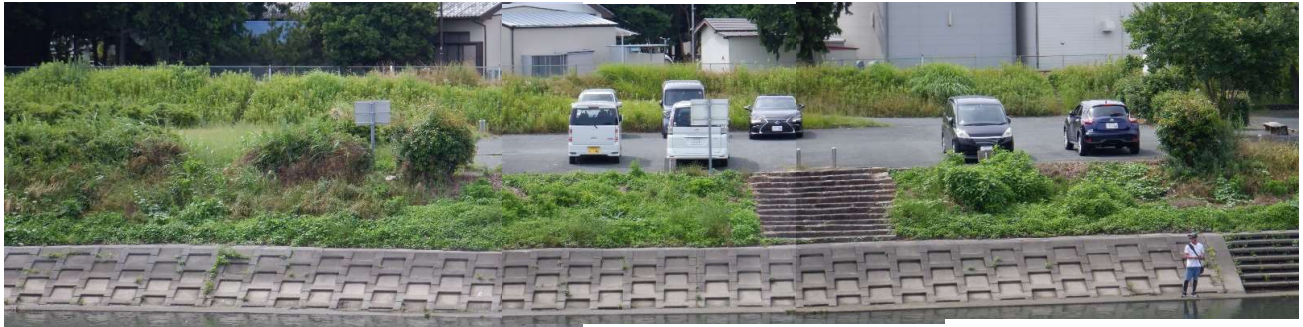
対岸から撮影2 着手前
