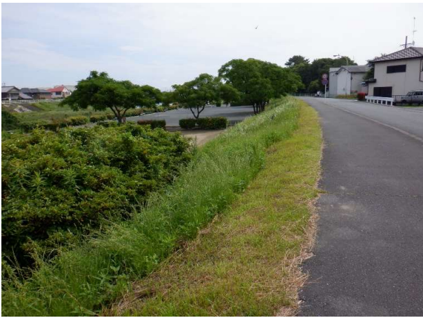
八幡瀬橋下流300m付近 着手前
