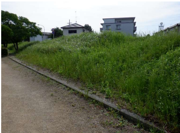
八幡瀬橋下流300m付近 着手前
