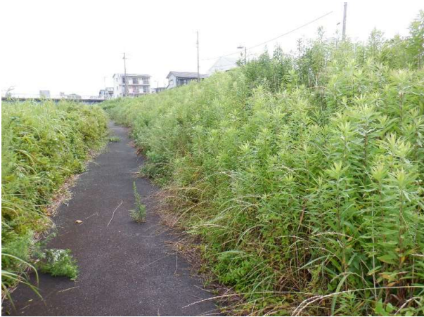
八幡瀬橋下流100m付近 着手前
