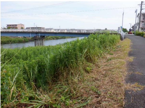
八幡瀬橋下流50m付近 着手前
