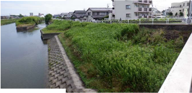
八幡是瀬橋から上流を撮影 着手前
