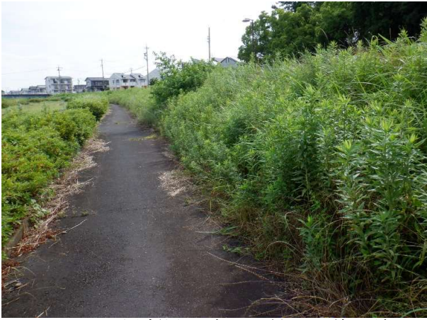
八幡瀬橋下流170m付近 着手前
