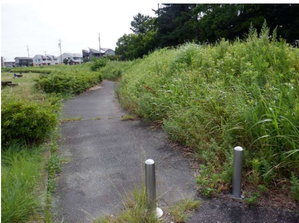
八幡瀬橋下流180m付近 着手前
