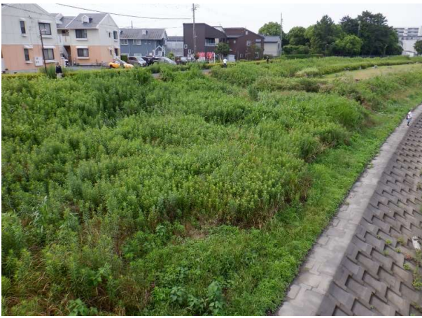
八幡是瀬橋から下流を撮影 着手前
