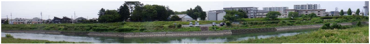
対岸から撮影1 着手前
