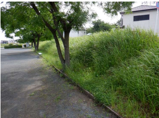
八幡瀬橋下流260m付近 着手前
