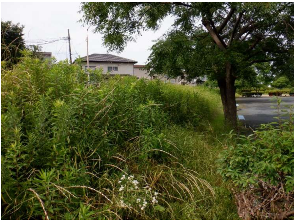
八幡瀬橋下流200m付近 着手前
