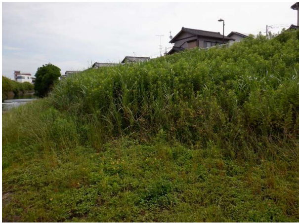
八幡瀬橋上流30m付近 着手前
