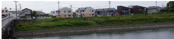
八幡瀬橋下流の対岸から撮影 着手前
