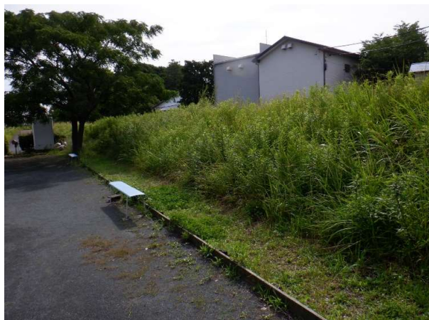
八幡瀬橋下流250m付近 着手前
