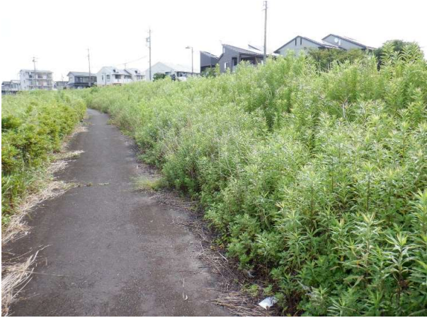
八幡瀬橋下流160m付近 着手前
