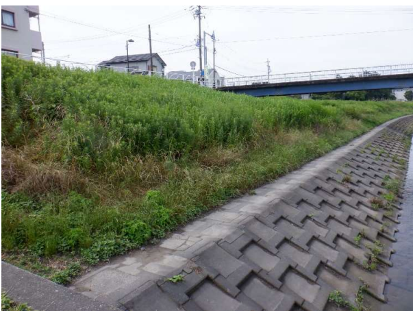
八幡瀬橋上流30m付近 着手前
